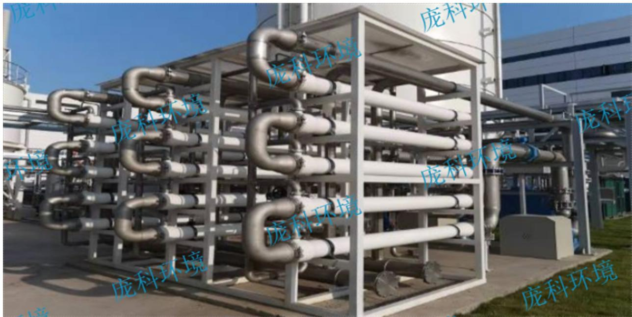
膜生物反应器[Membranebioreactor]MBR]是一种新型高效的污水处理技术，将传统生物处理工艺与膜分离技术有机结合起来。与传统生物处理技术相比[MBR]具有出水水质好、抗冲击能力强、操作管理简单、占地面积小、水力停留时间与污泥停留时间分离等优点，因此日益受到污水处理行业的关注[MBR]主要通过膜的物理截留作用，使硝化菌富集在好氧池内，延长污泥泥龄，满足硝化菌的生长繁殖需要，减少了硝化菌的流失，从而满足了脱氮的条件。高负荷好氧脱氮膜反应器的益处是整个系统中污泥混合液以平推流的形式流动，而在单个隔间内呈全混流态，加之回流装置使得整个反应器混合度高，传质效果好。
