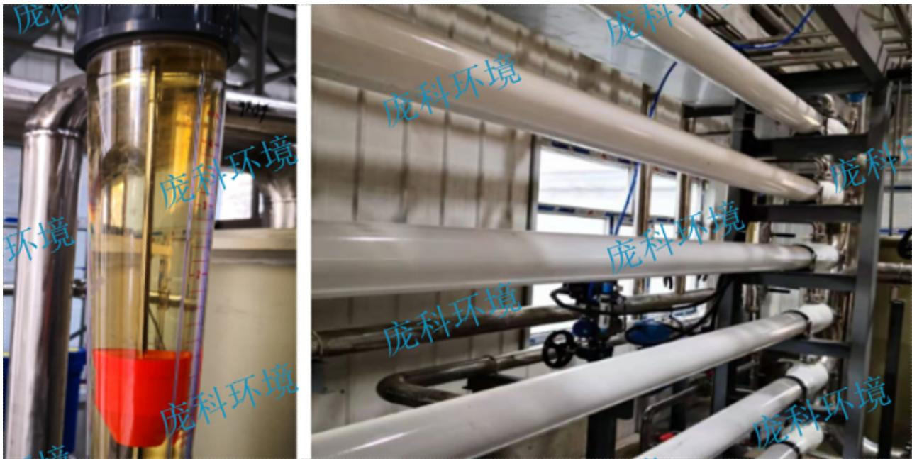
高负荷好氧脱氮膜反应器出水不含悬浮物，水质清澈透明，便于进一步深度处理或回用。一体化生物脱氮反应器是在低溶氧控制、微孔曝气软管、氧化沟回流内循环等技术基础上开发的一种新型生物处理技术，具有同步脱氮、能耗低、净化效率高、耐冲击负荷等诸多特点，在高COD、高氨氮、较难生物降解有机废水处理中具有明显的工艺优势。上海庞科环境是一家具有自主关键技术的环境公司，拥有厌氧反应器、外置管式膜AO脱氮反应器、MBR好氧反应器、臭氧催化反应器、臭氧催化剂、除磷沉淀器、VOCs治理和除臭等十多种技术产品。脱氮反应器能实现胶状COD的去除，取得更好的出水水质。青岛平板膜脱氮反应器价格
