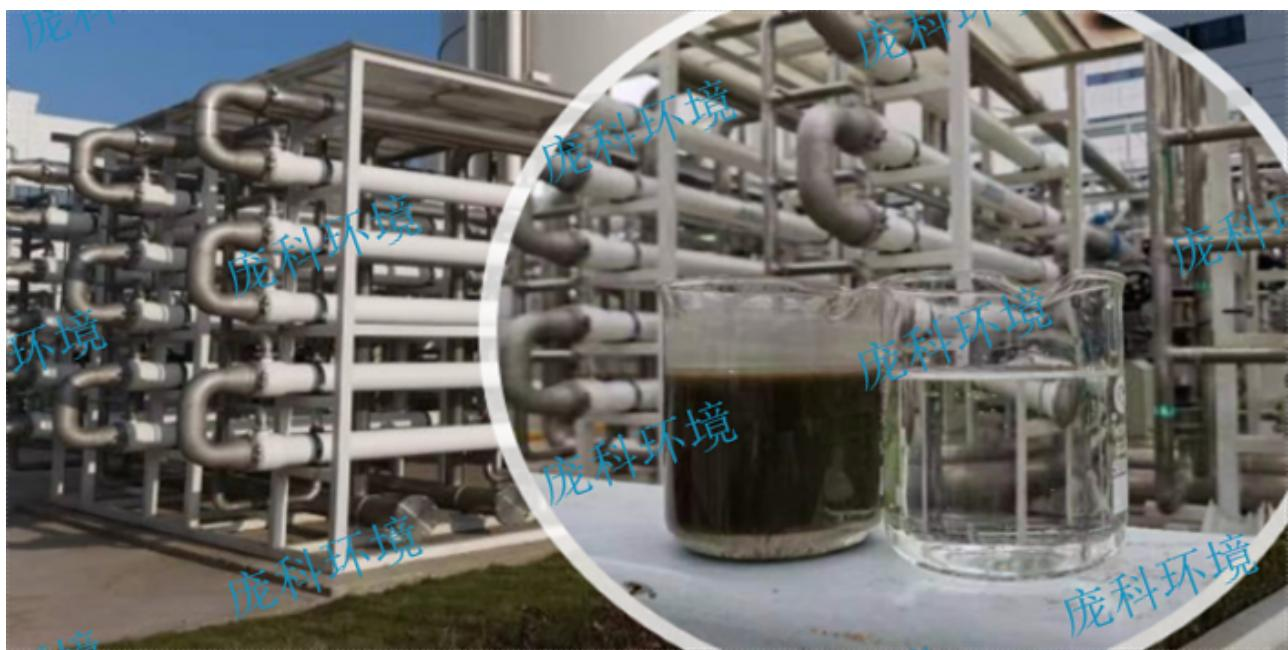
高负荷好氧脱氮膜反应器的原理：管式膜或平板膜分离使污水中的大分子难降解成分，在AO生物反应器内有足够的停留时间，从而提高了难降解有机物的降解效率。反应器在高容积负荷、低污泥负荷、长泥龄下运行，可以实现很低的剩余污泥排放；同时膜能够截留几乎所有的微生物，尤其是针对难以沉淀的、增殖速度慢的微生物，因此系统内的生物相非常丰富，活性污泥驯化、增量的过程缩短，处理的深度和系统抗冲击的能力得以加强，处理水质稳定；而独特设计的高负荷AO脱氮系统保证了稳定的COD、氨氮和总氮去除效果。青岛平板膜脱氮反应器价格高负荷好氧脱氮膜反应器罐体式设计，可全密闭，避免废气排放，更加友好的周边环境。
